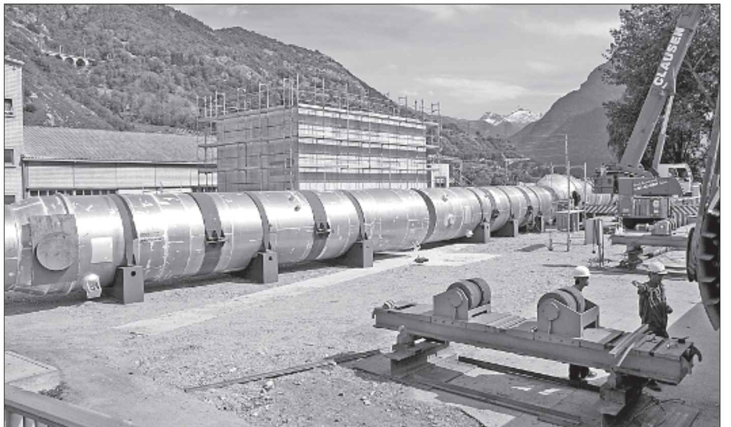
Die rund 60 Meter lange Hauptkolonne wird in den kommenden Tagen zusammengeschnitten und für den vertikalen Einbau vorbereitet. Foto zvg
