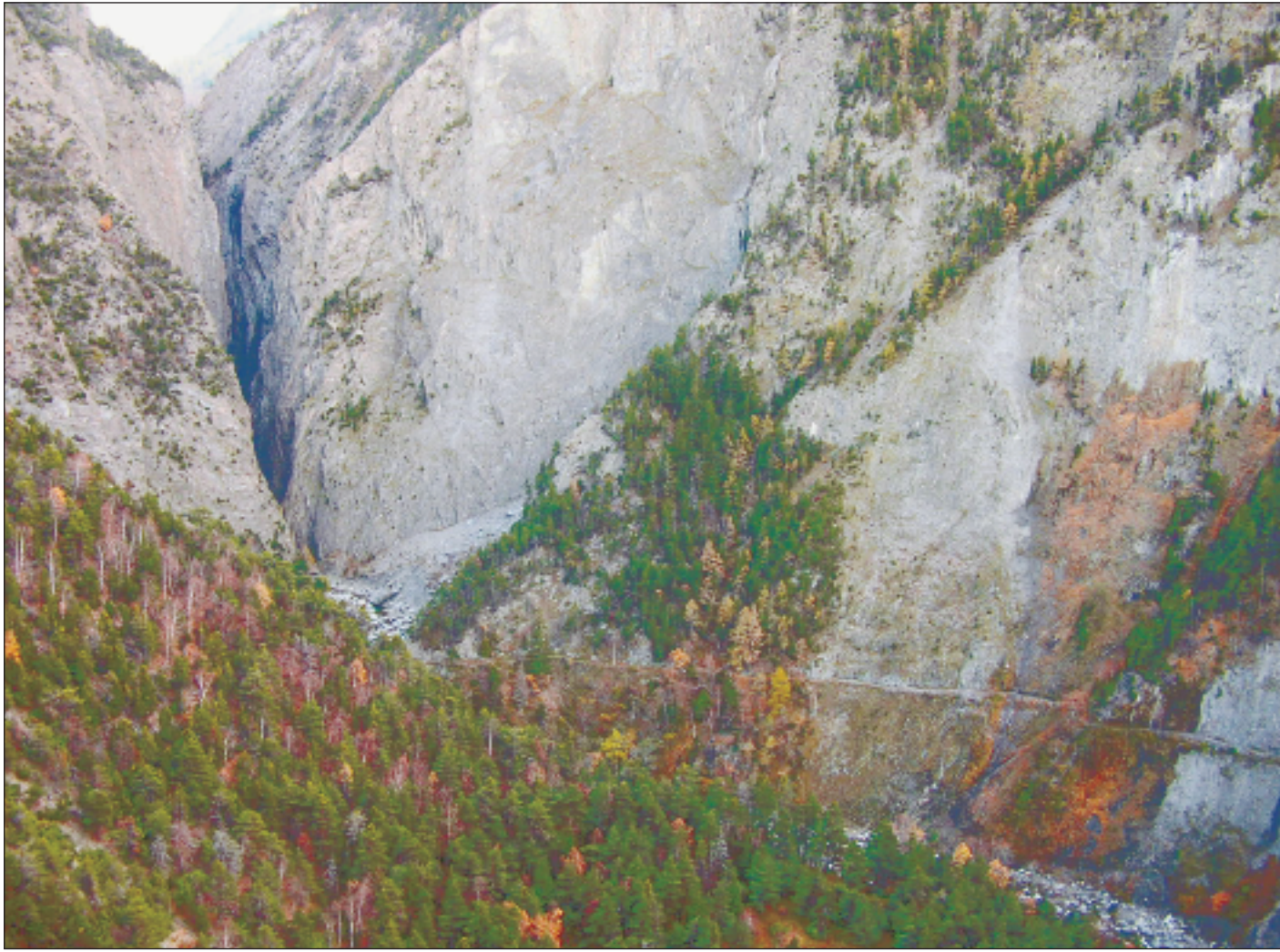
Der Termin für die Eröffnung des Erlebnisweges durch die Saltinaschlucht kann nicht wie geplant eingehalten werden. Geologische Probleme zwingen zu einer Projektüberarbeitung. Foto wb
