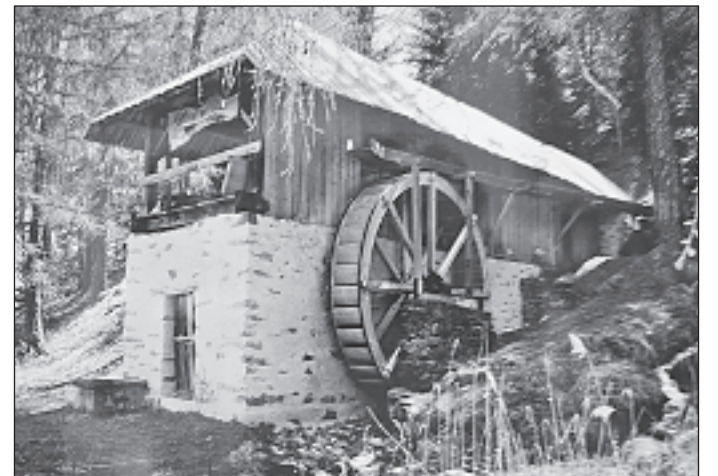
Die Wasserföhren betrieben und betreiben heute noch kleine industrielle Anlagen wie die Sägeerei von Nax belegt. Sie ist voll funktionsfähig und wird über das Wasser der Bisse de Nax betrieben.
